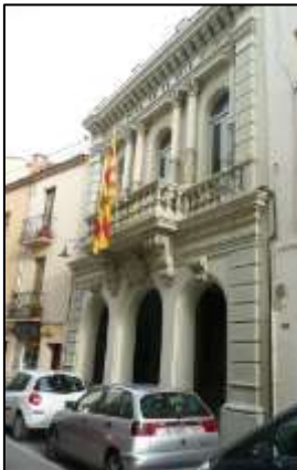
Casa de la Vila , c. 11 de Setembre, 4
