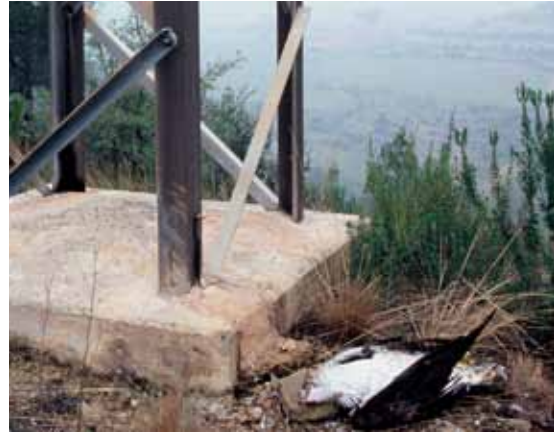
Fotografía 18. Ejemplar de águila perdicera electrocutada en un apoyo eléctrico. Autor: EBC-UB.
