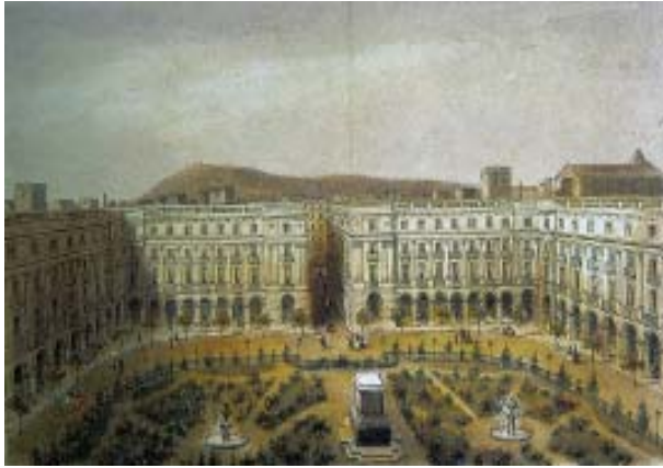
Vista de la plaza con el pedestal al monumento a Fernando el Católico aún erguido. La primera piedra de este monumento se colocó en 1850. Hacia 1860 se coloca de forma interina una copia en yeso del monumento que estaba trabajando Josep Piquer para ser fundido en metal
