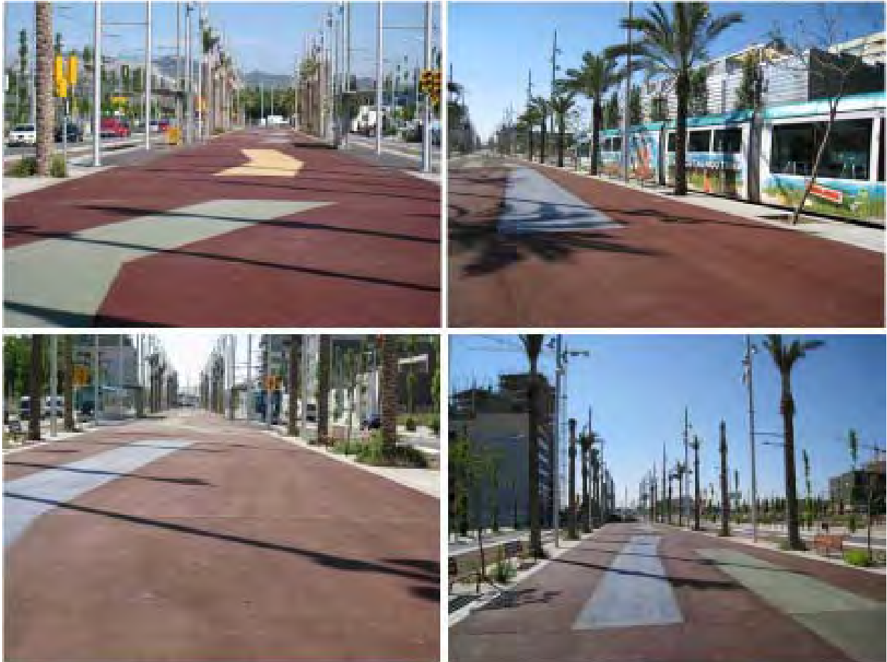
Vistas do estado actual de execução da Rambla de La Mina Fonte – Remesar, 2008
