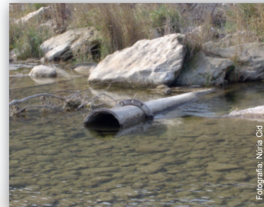
Figura 3. L'estrazione d'acqua è uno degli impatti più forti che subiscono i fiumi temporanei mediterranei.
