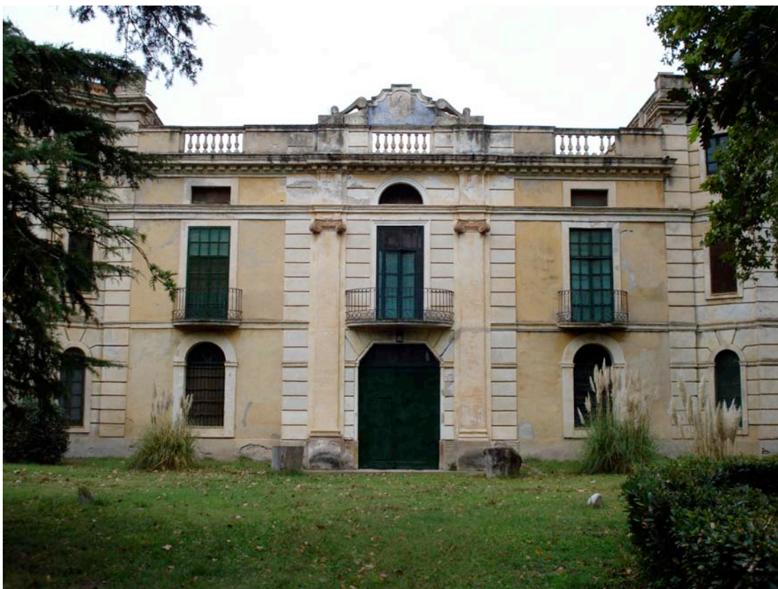
FIGURA 1: Fachada principal del antiguo edificio de la Granja-escuela de Fortianell (Fortià, Alt Empordà) en la actualidad (Fotografía de J. Burgueño).
