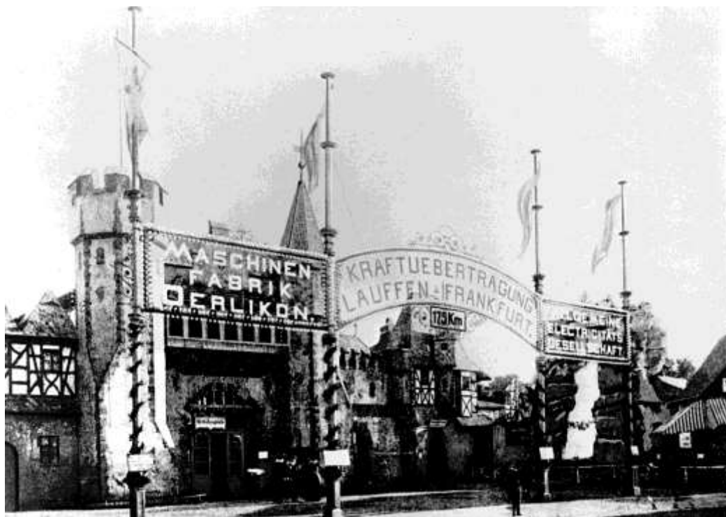
Figura 1. Entrada a la Exposición Internacional Electrotécnica de Frankfurt am Main, 25 de agosto de 1891. El arco de las arcadas era equipado con 1000 bombillas de luz, la corriente eléctrica se transmitía a través de una línea de transmisión de 175 km desde Lauffen am Neckar al recinto ferial. Al fondo, se puede ver la cascada de agua artificial.
