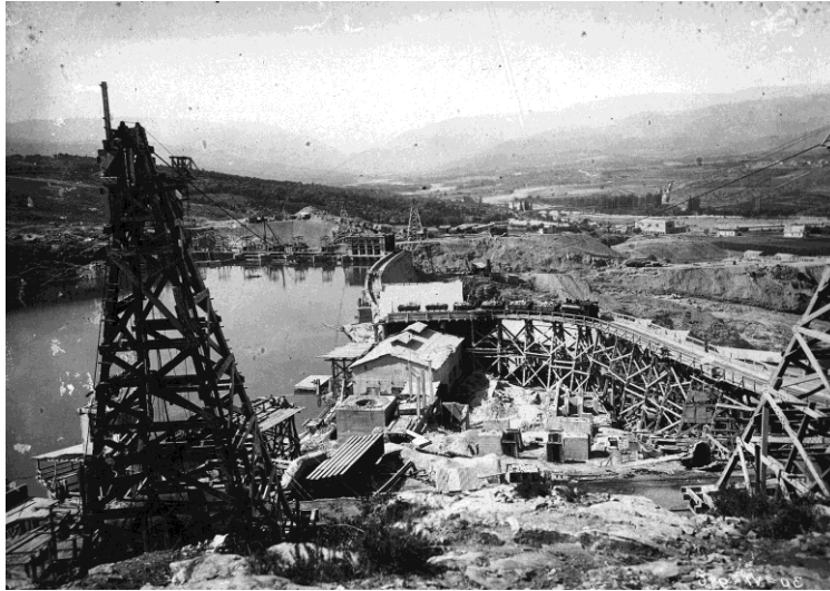
Figura 2. Presa de Sant Antoni. Infraestructuras y sistemas de construcción en las obras de la presa del embalse de Sant Antoni. Año 1916.
