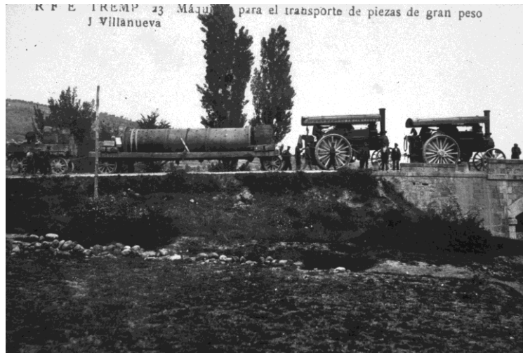
Figura 10. Tren renard de Riegos y Fuerza del Ebro. Está transportando una tubería de grandes dimensiones para la central de Talarn. Años 1912-1916.
