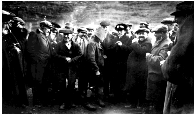
Figura 13. Visita de personalidades. El ministro de Fomento español, Miguel Villanueva, visitando las obras de la central de Capdella acompañado de Emili Riu y de otras autoridades y habitantes de la zona. Enero de 1913
