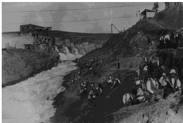
Figura 4. Vista general de las obras de construcción de la presa de Sant Antoni. Años 1912-1916.
