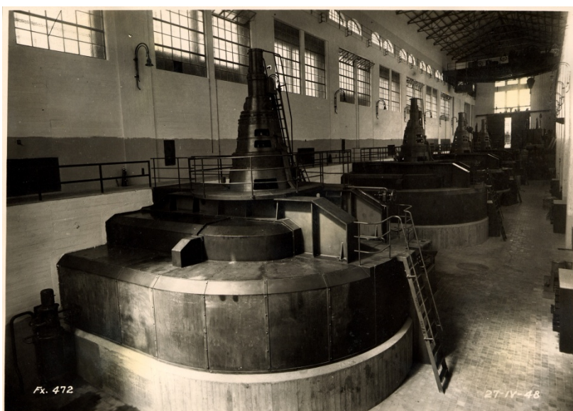
figura 5: La central acabada. (FHFE)
