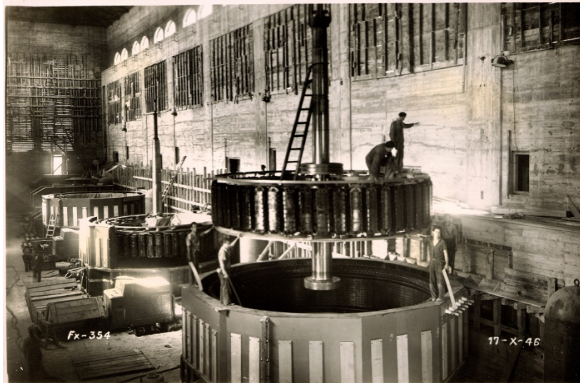
figura 3: Interior de la central. Instal·lació del rotor dels generadors elèctrics. (FHFE)
