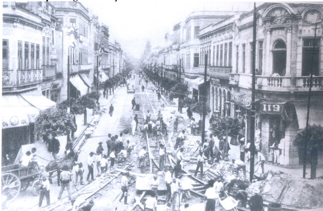
Figura 05: Obras de assentamento de trilhos para bondes na rua Uruguaiana, executadas pela Light – março de 1909
