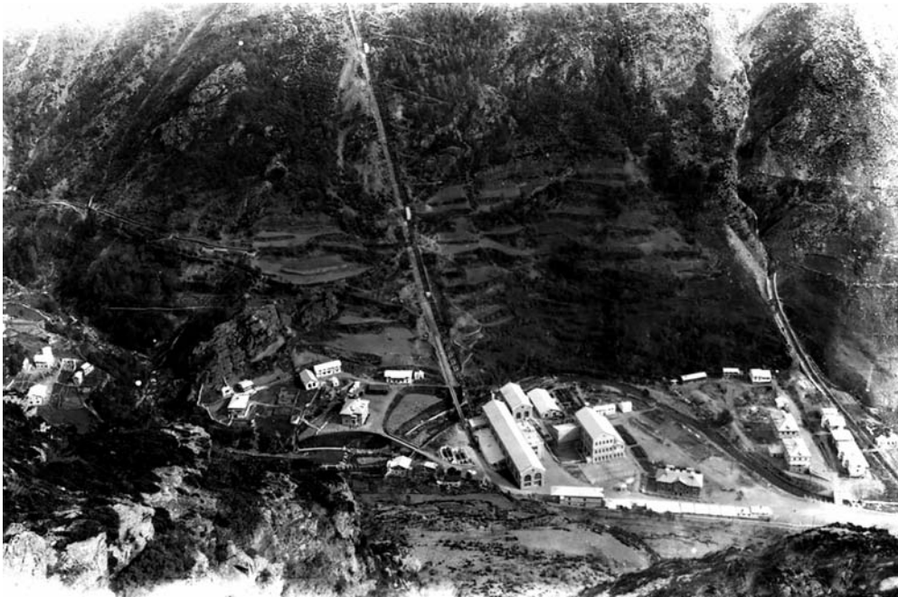
Figura 4: Tubería, central hidroeléctrica y campamento de Capdella.
