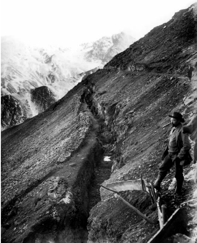
Figura 2: Construcción del Canal de Estangento hasta la Cámara de agua.
