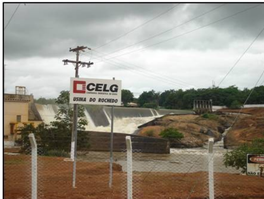
Figura 1: Pequena Central Hidrelétrica de Rochedo.
