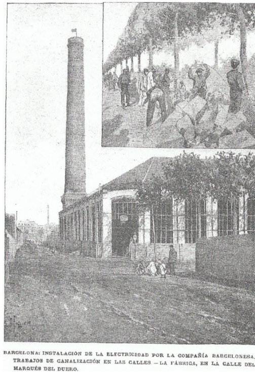
Figura 2. Trabajos de canalización del cableado eléctrico en las calles de Barcelona y central térmica de la Compañía Barcelonesa de Electricidad (1896). Fuente: La Ilustración Ibérica . Barcelona, 19 de diciembre de 1896, p. 805.
