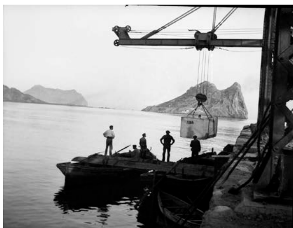
Figura 13. Colocación bloque. Fuente: AGRM. FOT_NEG 018/79.
