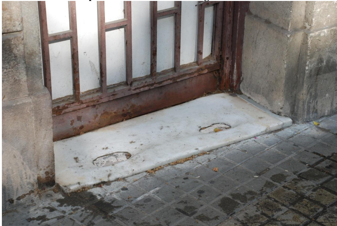
Figura 5. Pedrís de la porteria de les Rambles nº 2 –actualment exposat a l’interior de la porteria- perforat i desgastat per l’acció dels talons de les sabates de les prostitutes de carrer al llarg del s. XX.
