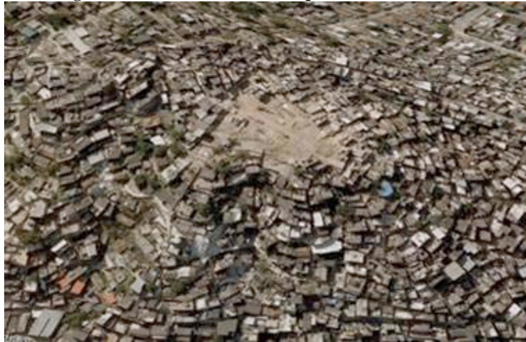
Figuras 2 e 3. Áreas removidas para as obras do PAC
