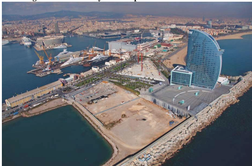
Figura 2. Imágenes del Hotel W y rellenos para la Marina Bocana Nord.
