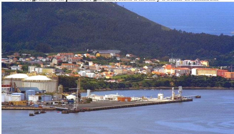
Figura 5. Fotografía de la planta de gas inmediata a la Ría y a zonas urbanizadas
