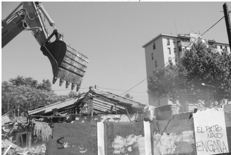
Figura 4. Demolición en calle Sas, abril 2007
