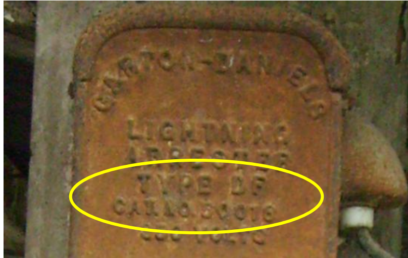
Figura 11. Detalle de tapadera de pararrayos mostrando los datos encontrados en el Western Electric Catalog 1916 Versión digital .
