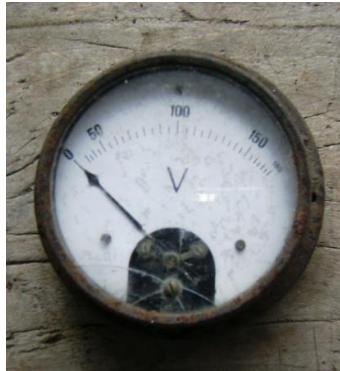
Figura 14. Voltímetro encontrado con el equipo eléctrico de San Julián.
