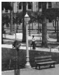
Fig. 8.1. Detalhe da imagem da Praça João Pessoa. Poste padronizado em estilo simples iluminação elétrica.
