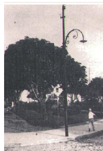
Fig. 8.2. Detalhe da imagem da Praça Pedro Américo. Poste em altura elevada com haste adornada para suporte da lâmpada utilizando energia elétrica.
