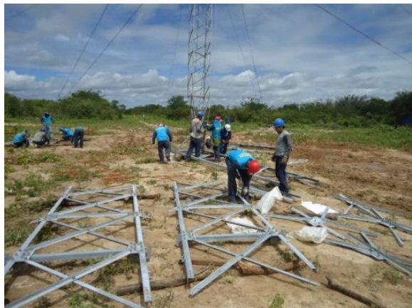
Figura 7. Montagem das torres de transmissão. Fonte: Parque Eólico Alegria, 2011.
