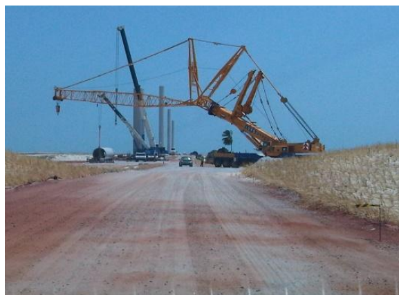
Figura 5. Etapa de instalação dos aerogeradores. Fonte: Parque Eólico Alegria, 2011.
