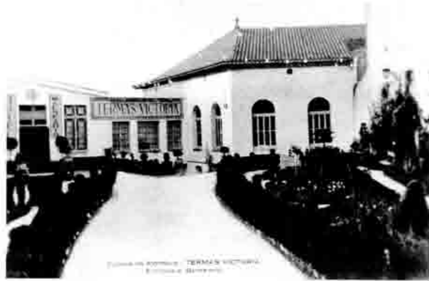
L'any 1923 l'enderroc de les primeres cases del carrer Barcelona va permetre portar a terme un seguit de reformes en el balneari Victòria. A més de les reformes interiors, a partir d'aquest moment l'establiment va disposar d'una àmplia entrada ajardinada (Arxius Thermalia).
