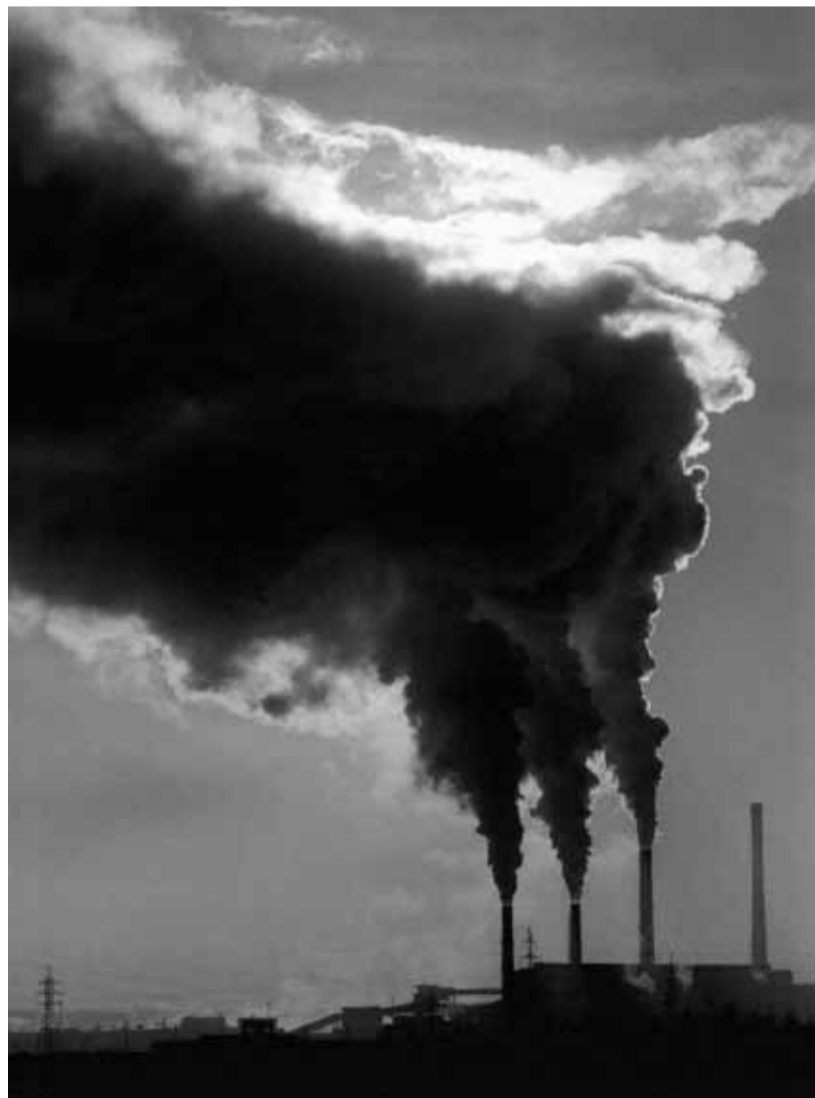
La central térmica de Chita, ubicada en Rusia
