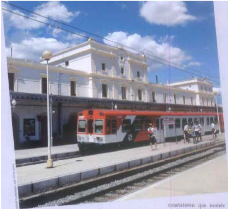
Un transport més net. Els grans problemes que afecten la xarxa de trens de rodalia de Barcelona no ajuden a reduir l'ús del cotxe. A la imatge, l'estació de Vilanova i la Geltrú.
