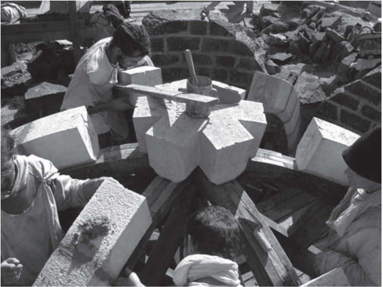
Figure 4. Construction de la voûte d'ogive.
