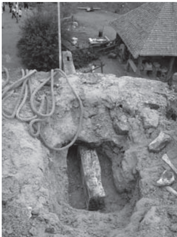
Figure 7. Boulin ancré dans la maçonnerie.
