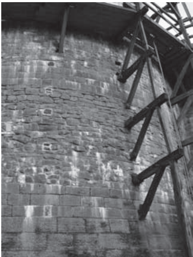
Figure 6. Appareil du mur et échafaudages ancrés.
