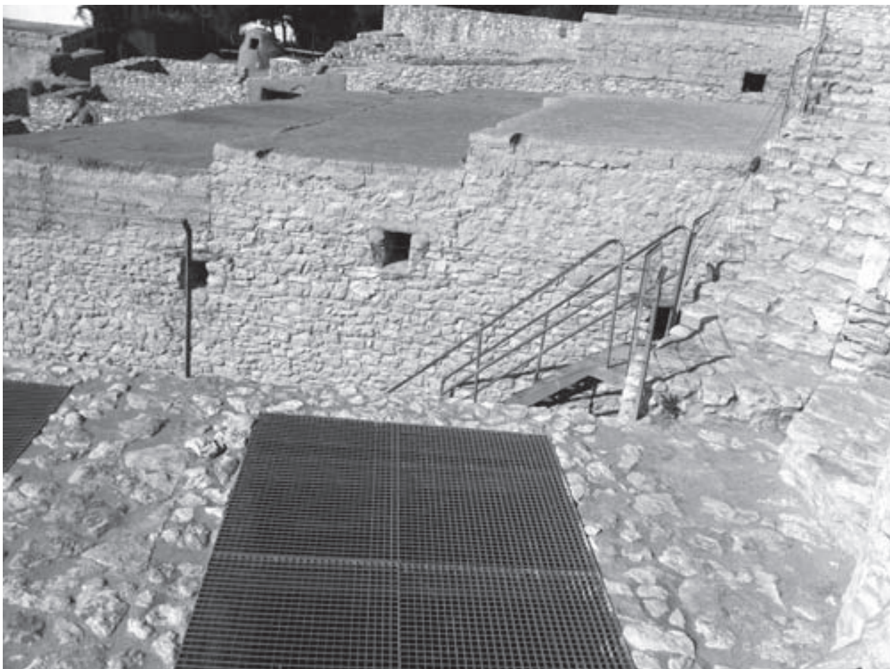
Figura 9. Detall de les cobertes del barri nord de la Ciutadella ibèrica de Calafell (foto: J. Santacana).
