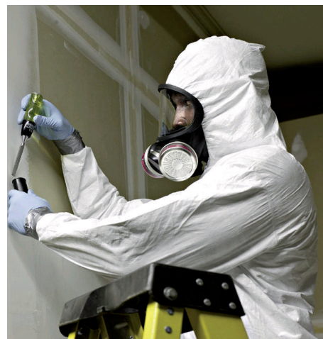
Retirada d'amiant d'un edifici afectat
