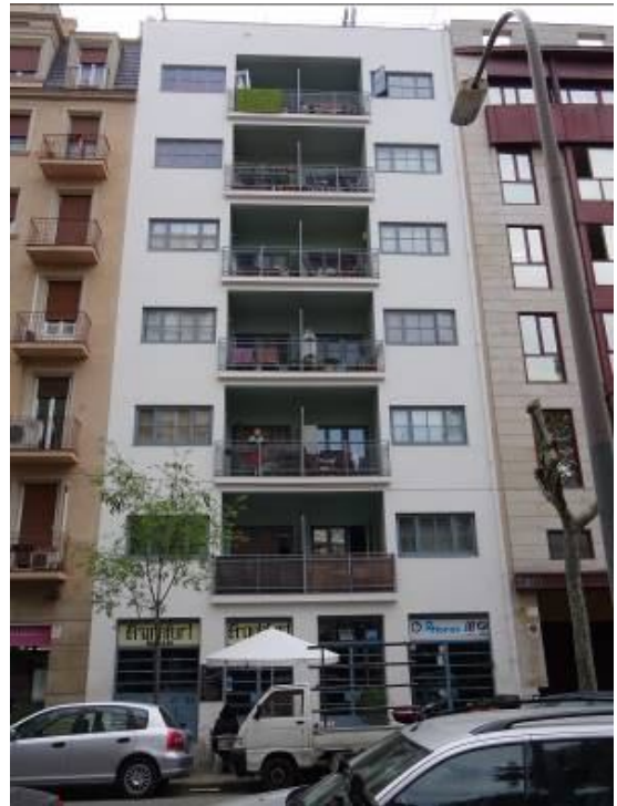
1929. Barcelona. Josep Ll. Sert. Edificio de Viviendas de alquiler en la calle Rosselló, 36. Los pilotis originales de la planta baja han desaparecido por las ampliaciones comerciales
