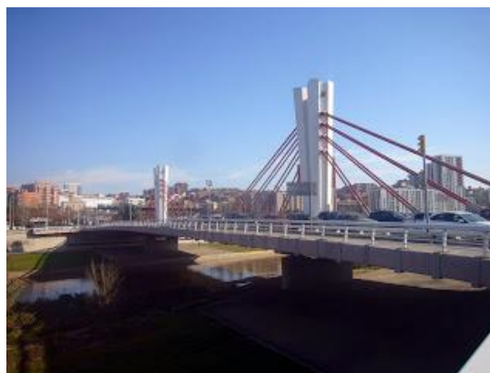
Nuevo puente de Potosí
