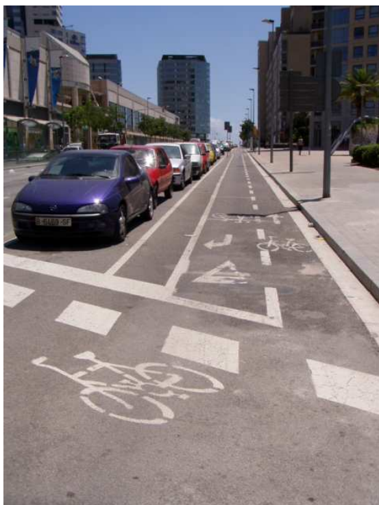
Carrer de Josep Pla, a l'àrea de Diagonal Mar. El carril bici es troba entre l'acera i la zona d'aparcament de vehicles. Entre aquesta zona i el propi carril hi ha un espai de seguretat a més d'unes bandes rugoses per facilitar l'aparcament.
