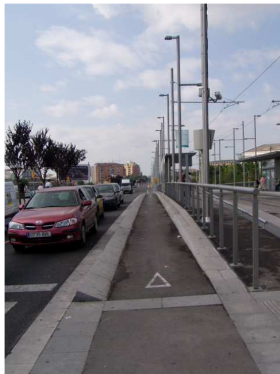
Avinguda Meridiana a l'alçada del Teatre Nacional de Catalunya, a Barcelona. El carril bici es troba entre el tramvia i la calçada amb un voladiu de seguretat.
