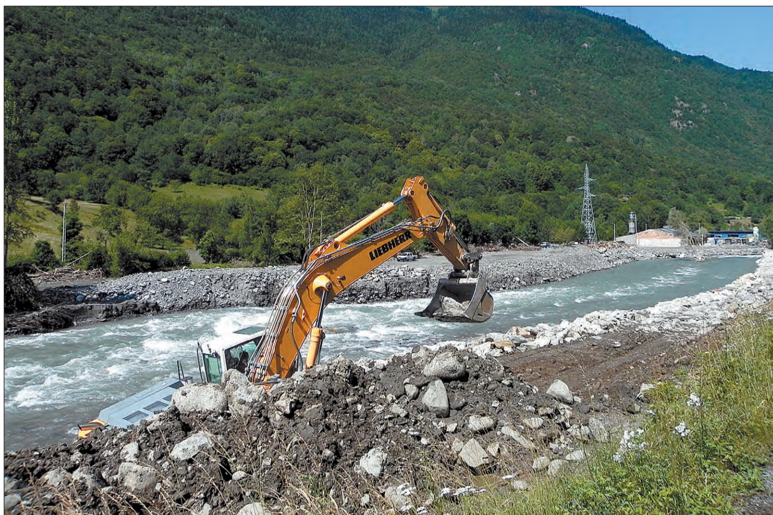
FOTO: FEM / Una màquina al riu Garona al seu pas per la Val d'Aran fent treballs fa uns anys per canalitzar-lo
