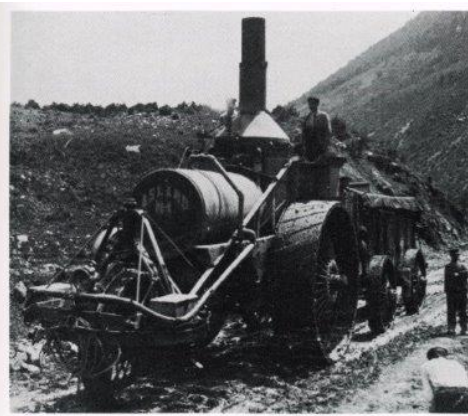
El tren Best travessant les obres de la carretera de Solsona a Ribes. Arxiu Mas (1904).
