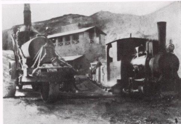
Malgrat la seva poca qualitat, en aquesta excepcional imatge es demostra el canvi de sistema de transport que es va veure obligada a fer Asland. A l'esquerra s'observa el tren de carretera Best, a la dreta la locomotora núm. 11 del ferrocarril. Col. E. Pujals.
