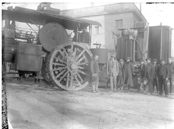
davant i un John Fowler al darrera, a la Plana de Montrós, camí de les obres de la central de Capdella. Arxiu Manel
