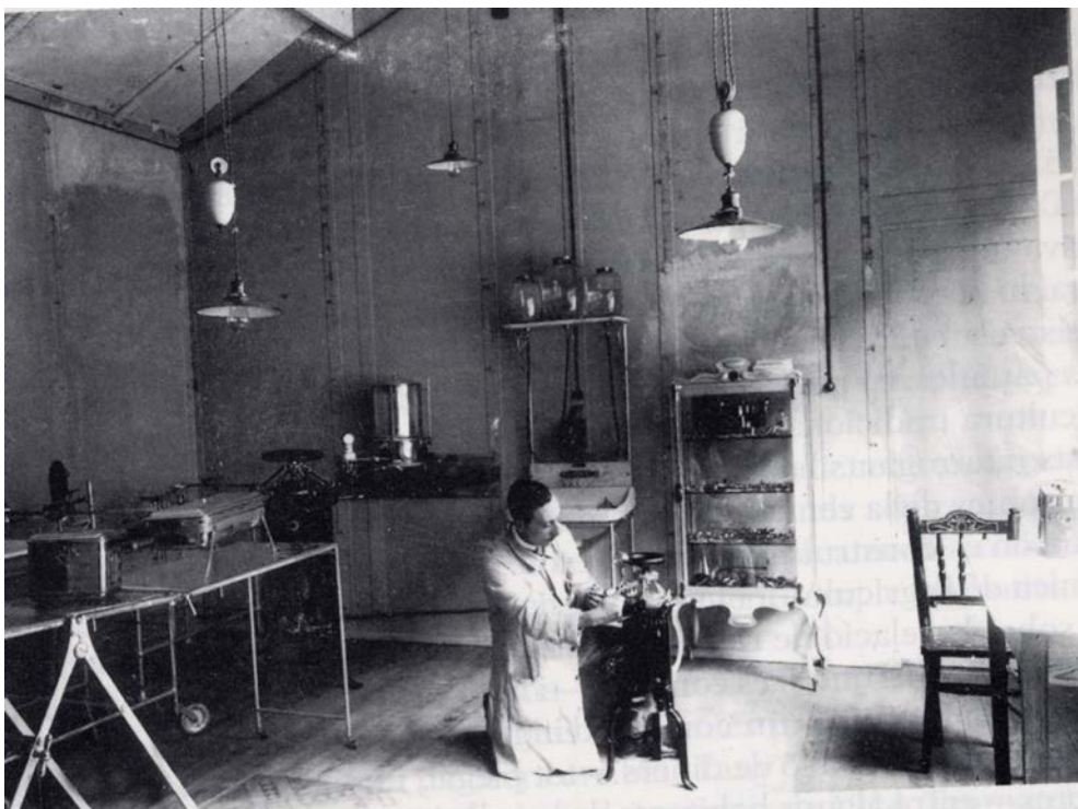
Figura 4. Interior de “L'hospital de cartó” de la Central de Capdella.
