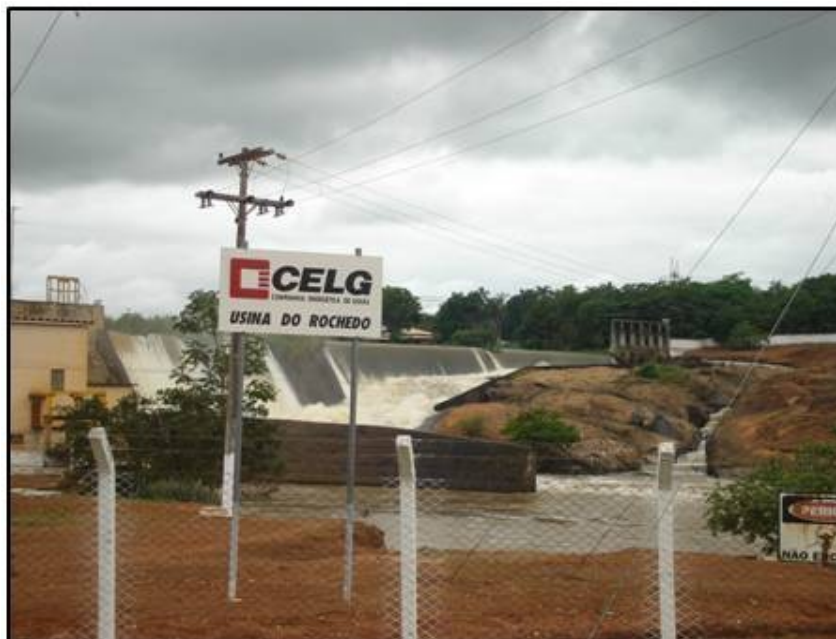
Figura 1: Pequena Central Hidrelétrica de Rochedo.
