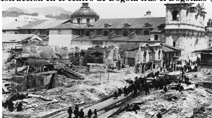
Figura 7. La destrucción en el centro de Bogotá tras el Bogotazo (1948)
