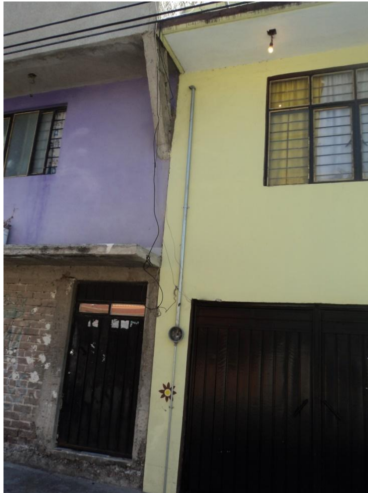
Figura 9. Casa con mufa instalada, pero sin medidor, y el foco prendido. Colonia vecina del parque industrial. No se tiene medidor pero sí el servicio de luz por estar colgado del sistema público de luz eléctrica. Foto de autoría propia, 2014.
