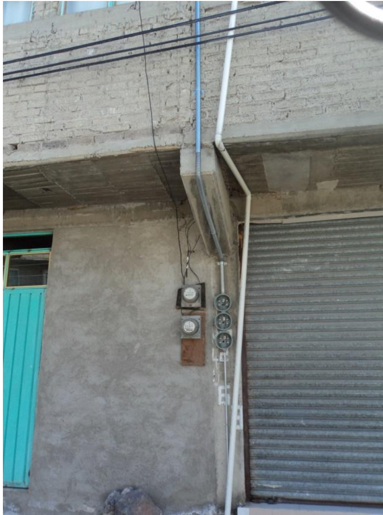
Figura 10. Casa con medidores análogos instalados y mufas para medidores digitales aun sin instalar. Colonia vecina del parque industrial. Foto de autoría propia, 2014.
