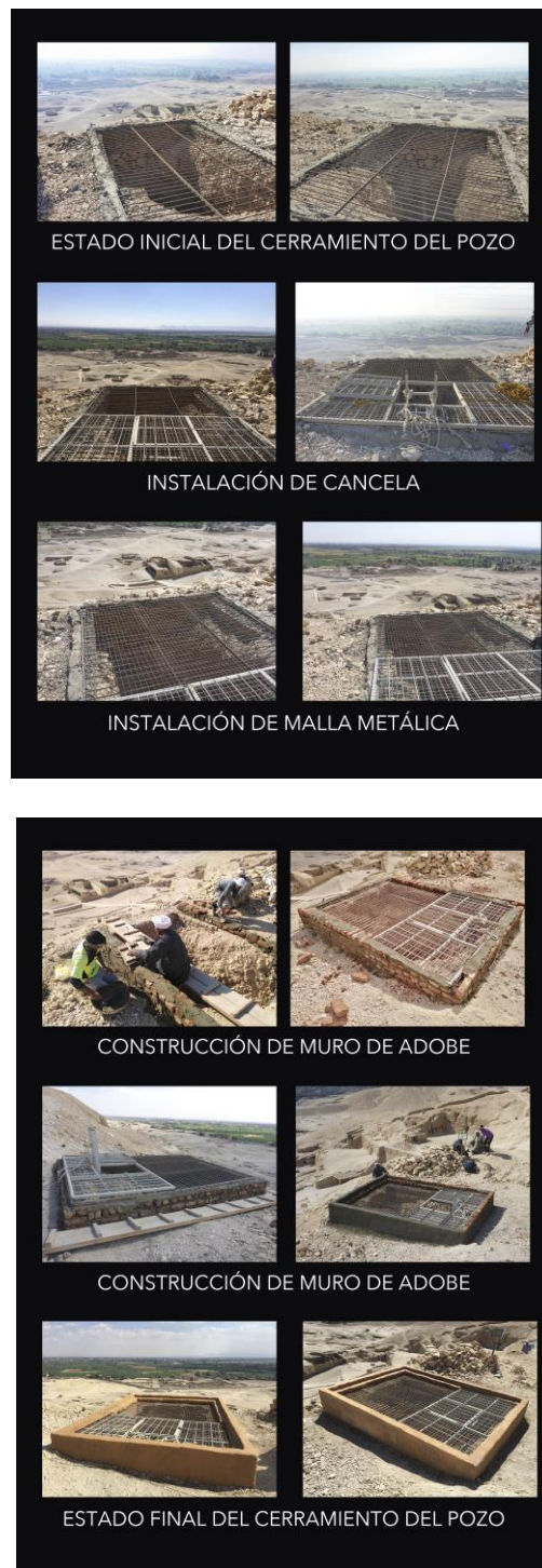
Fig. 15: Estado de la boca del pozo que da acceso a la cámara funeraria de TT 87 antes y después de acondicionarla. © FIL-MAT/Carmen Ruiz.
