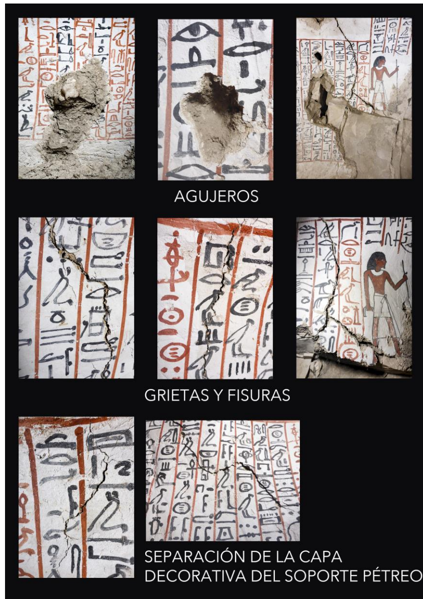
Fig. 13: Principales factores que afectan al estado de conservación de las superficies decoradas en la cámara funeraria de TT 87. © FIL-MAT/Carmen Ruiz.
