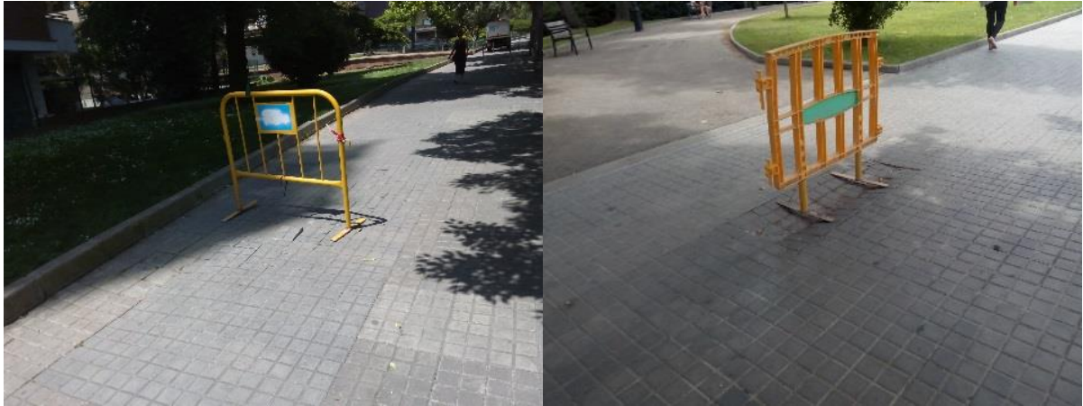
Figura 11. Senyalització de paviment en mal estat al carrer Pintor Francisco Ribalta (esquerra) i Av. Diagonal (dreta).
