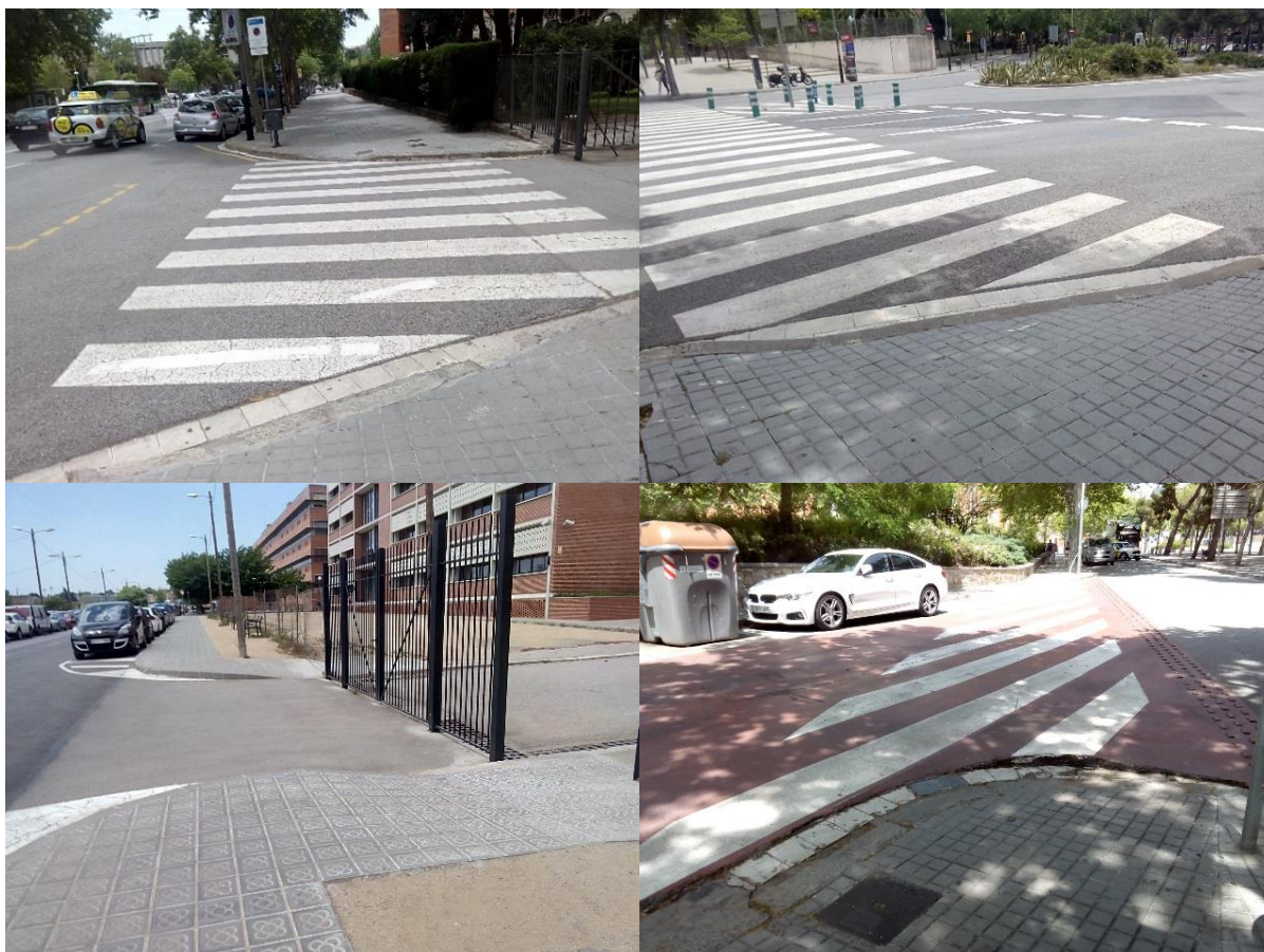
Figura 22. Rebaixos de vorera que no compleixen normativa a l'Av. Joan XXIII (superior i inferior esquerra), i al carrer Menéndez Pelayo (inferior dreta) .
