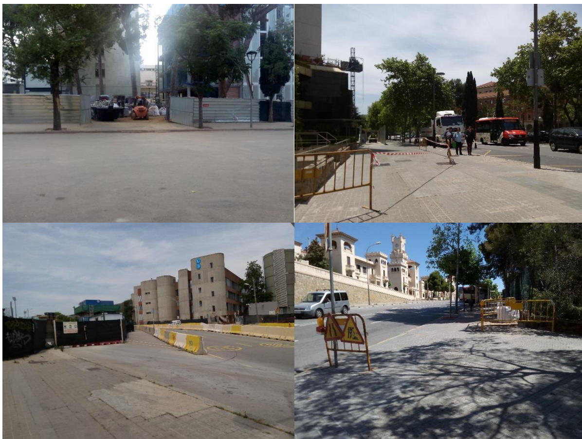
Figura 13. Exemples de barreres arquitectòniques provisionals: obres del nou edifici de la facultat de Dret al carrer Pere Duran Farell (superior esquerra), obres a l'Hotel Princesa Sofia a l'Av. Joan XXIII (superior dreta), obres de la línia L9 del metro a l'Av. Dr. Marañón (inferior esquerra) i obres al carrer l'Exèrcit (inferior dreta).
