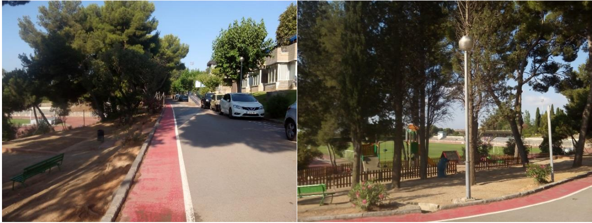
Figura 33. Barrera arquitectònica: escales per accedir a la zona de llocs infantils.
