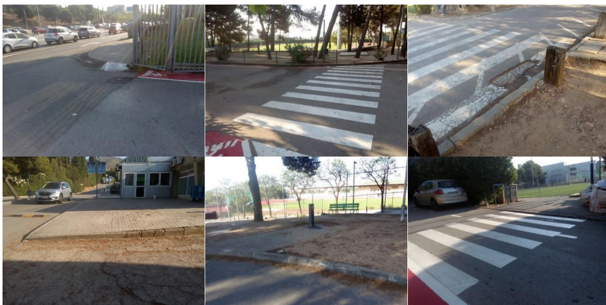
Figura 32. Exemples de voreres sense rebaixos o que no compleixen la normativa al recinte d'Esports UB: entrada al recinte (superior esquerra), vial per anar de l'edifici administratiu a la pista d'atletisme (superior centre), pas de vianants entre la pista d'atletisme i el camp de rugbi (superior esquerra), vorera entre la pista d'atletisme i el camp de rugbi (inferior esquerra), accés a la zona de descans entre la pista d'atletisme i el camp de llançaments (inferior centre), i vorera entre la pista d'atletisme i el camp de gespa artificial (inferior dreta).
