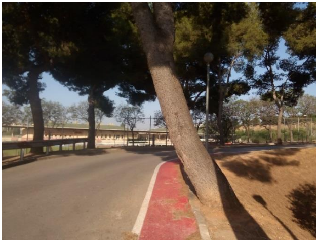
Figura 34. Arbre dificultant el pas dels vianants per la zona senyalitzada.
