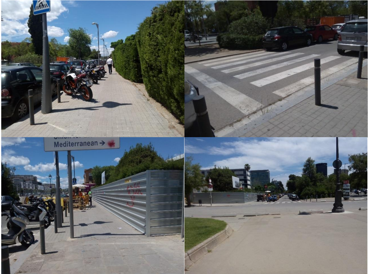
Figura 1. Aparcament de motos sobre vorera (superior esquerra), manca rebaixos pas vianants (superior dreta), obres provisionals (inferior esquerra) i manca de pas de vianants (inferior dreta).
