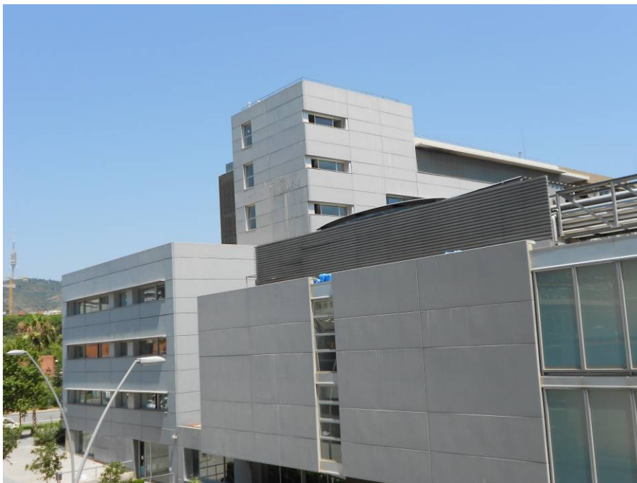
Figura 5. Ampliació de les facultats de Física i de Química, des del carrer de Pascual i Vila. Font: Banc d'imatges OSSMA.
