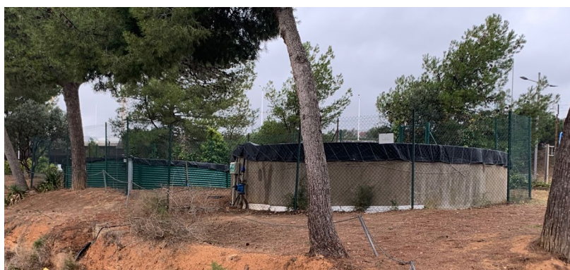
Dipòsits d'acumulació d'aigües freàtiques.
